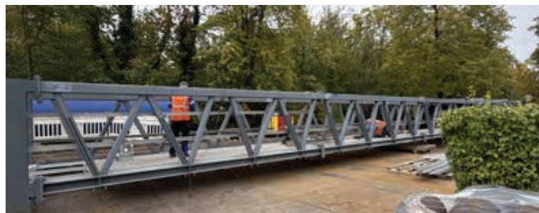
Über diese Medienbrücke führt künftig die Fernwärmeleitung der Sömmerdaer Energieversorgung. Sie wird vor die Bahnbrücke gesetzt.
