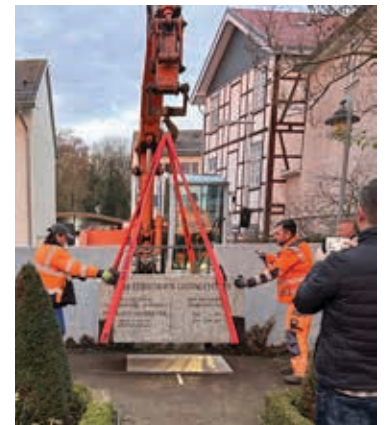
Der knapp vier Tonnen schwere Sockel wird über die Mauer des Rosengartens am Dreyse-Haus gehoben (links). Mitarbeiter des Betriebshofes tarieren den Sockel aus.
