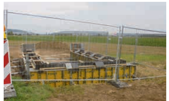
Bei Großbrennbach ist die Fläche für den Rastplatz bereits gepflastert. Zwischen Kindelbrück und Riethgen laufen die Erdarbeiten für das Fundament des Rastplatzes.
