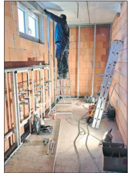
Auch Mitarbeiter der Firma Ersba-bau GmbH arbeiten am Neubau des Sozialtraktes für die Feuerwehr Leubingen mit. (Foto: Matthias Sack)
