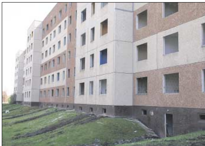
Gegenwärtig werden in der Offenhainer Straße 4 - 26 Entkernungsarbeiten durchgeführt.
